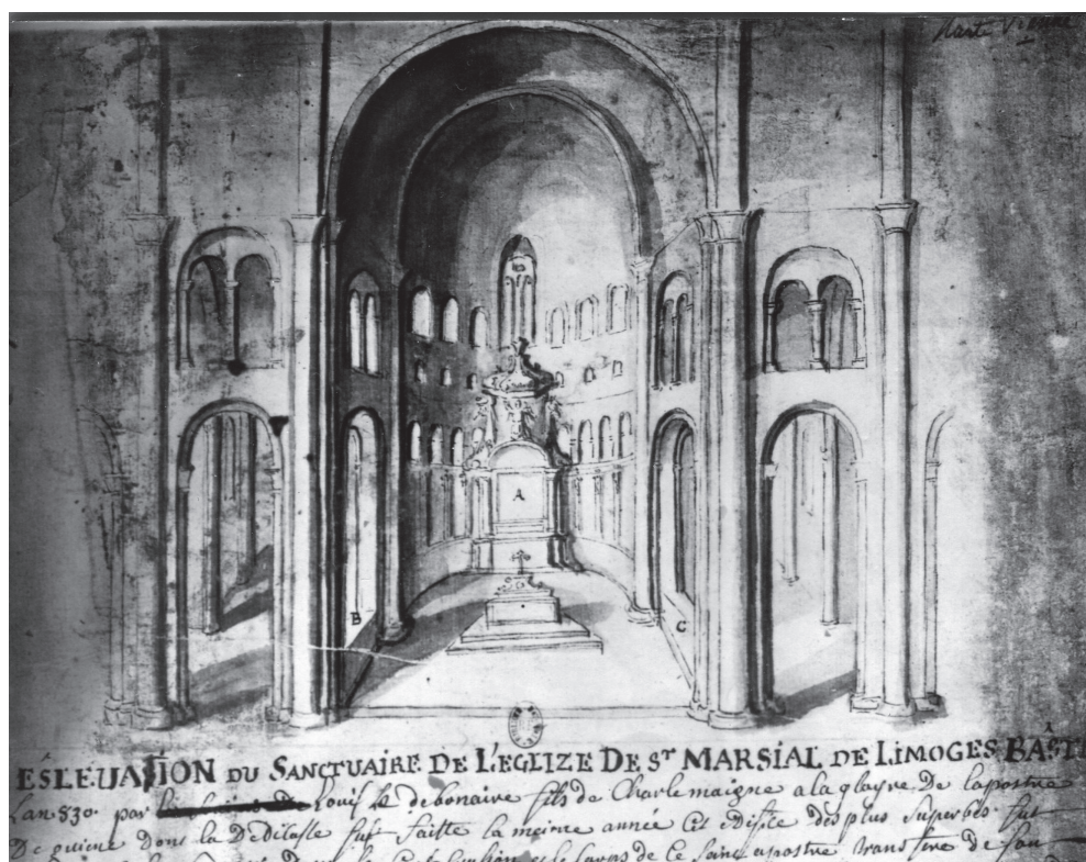
Fig. 3 - Limoges, Saint-Martial, abbatale du sauveur, vue intérieure du sanctuaire (Paris, BnF, Est. Va 87). Cliché BnF
