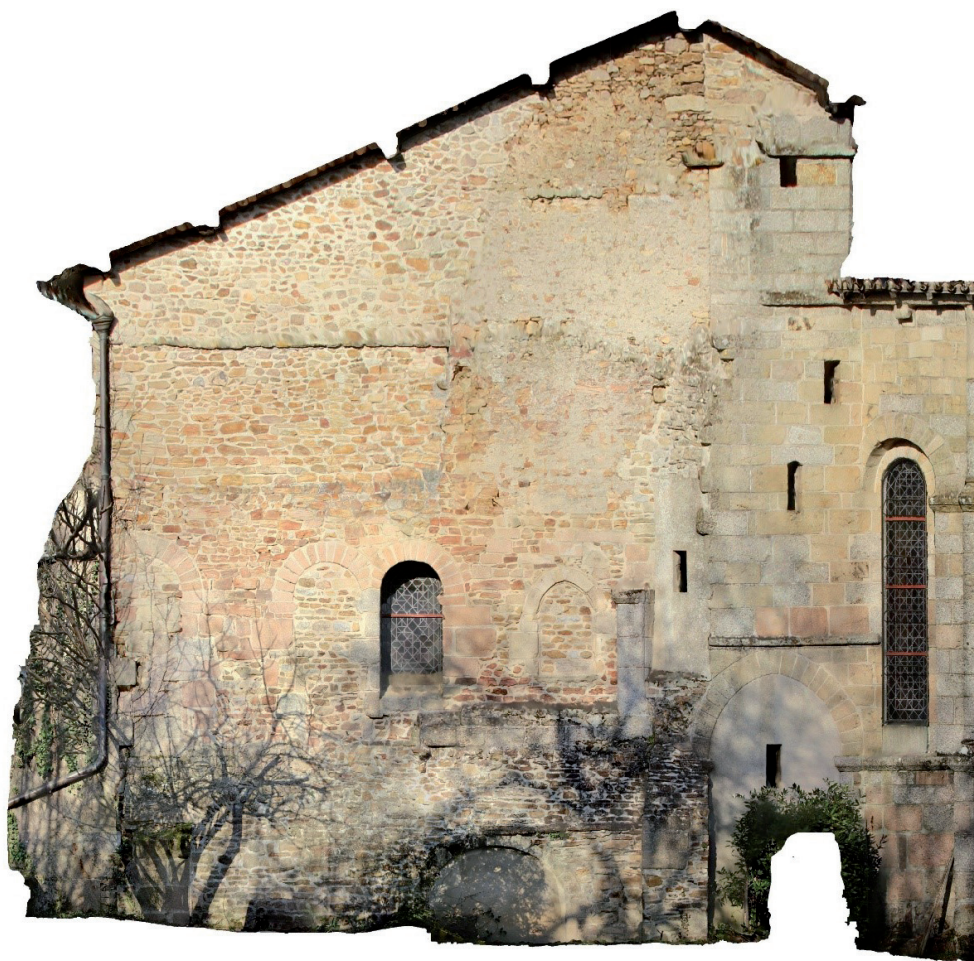
Orthophotographie de la façade du bras sud du transept en vue de l'étude archéo-monumentale de cette partie de la collégiale peu explorée. ( Topographie et conduite de drone : Boris Hollemaert, Èveha ; photographie et traitement photogrammétrique : Nicolas Saulière, Èveha )
