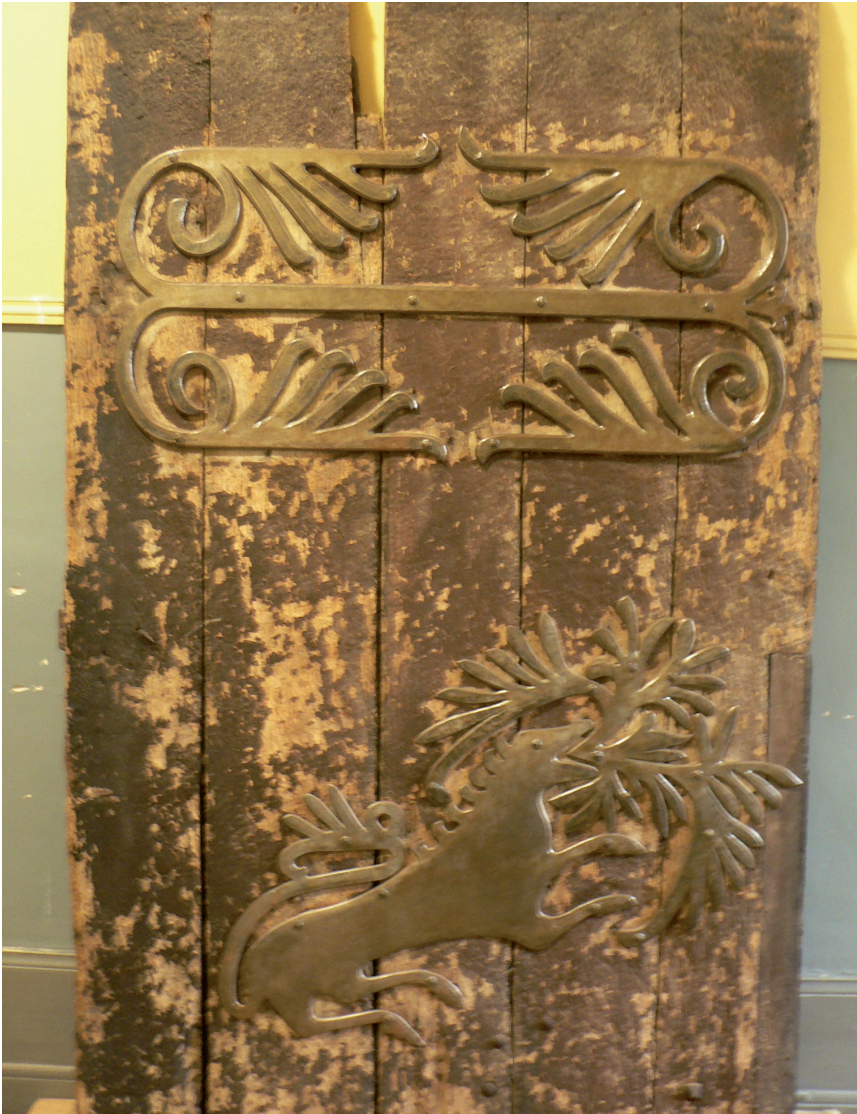
Partie du vantail porte nord sous le clocher avec fausses pentures reproduites par l'Atelier de ferronnerie de l'Atelier du Mazet « Apprentis d'Auteuil » à Saint-Just-Le-Martel (87) en 1985. Coll. CSSL.
